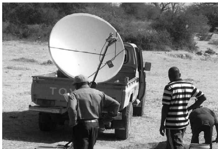
Figura 12 – Instalação da antena VSAT na Oficina do Manquete
