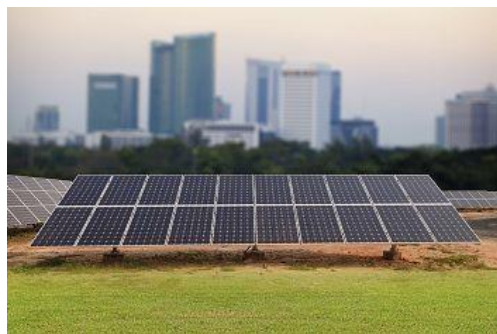
Painéis solares fotovoltaicos
