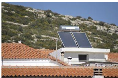
Placas Solares Fotovoltaicas
