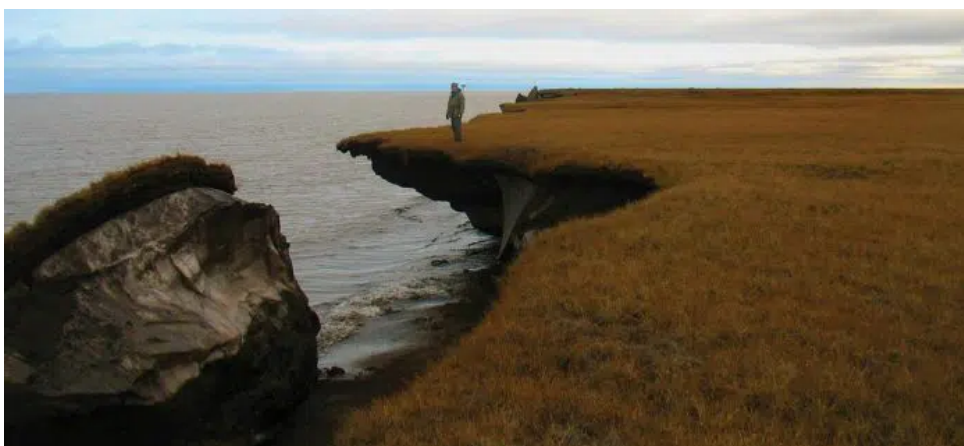
Foto de USGS/Christopher Arp | A erosão do permafrost na Costa Ártica do Alasca.
